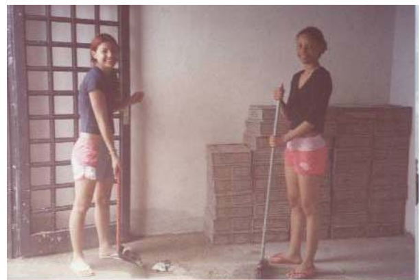
Umbauarbeiten in der „Casa Carolina“
